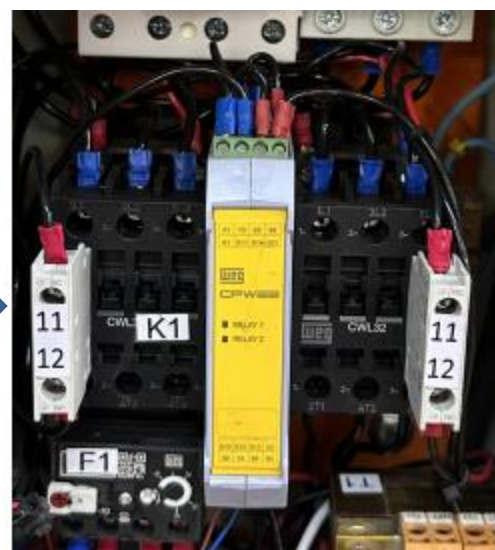
Sistema atual com 2 contatores em série e relê com botão liga e desliga no quadro
